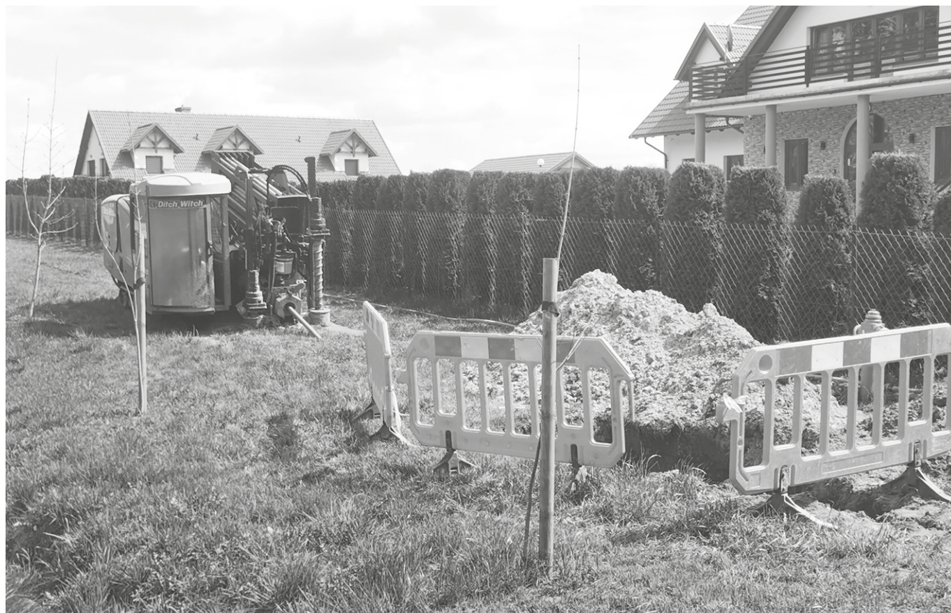
Bezwykopowa budowa sieci wodociągowej na linii Ruda – Kleszczewo – Rydzewo
