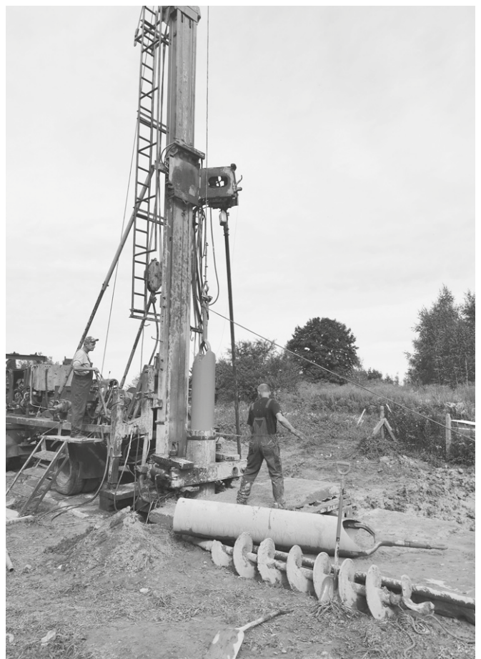
Budowa studni głębinowej nr 5A
