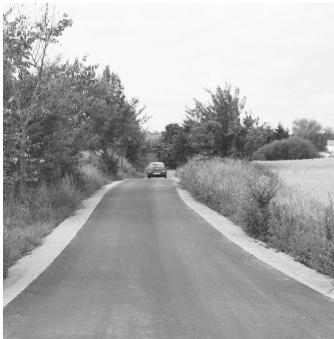
Nowa droga asfaltowa w Przykocie
