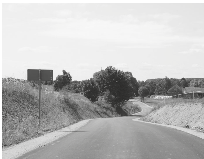
Nowa droga asfaltowa w Paprotkach
