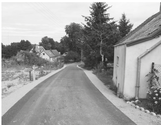
Nowa droga asfaltowa w Wyszowatych
