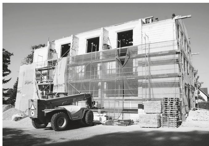
Trwają prace budowlane przy remoncie i termomodernizacji miłkowskiego Ośrodka Zdrowia
