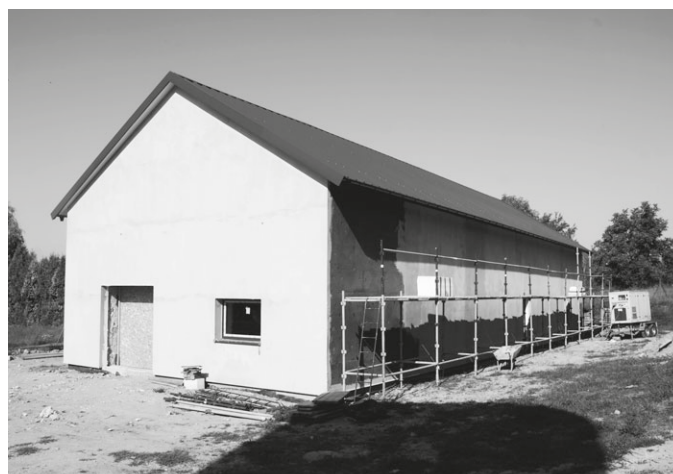
Modernizacja stacji uzdatniania wody w Miłkach jest już na ukończeniu
